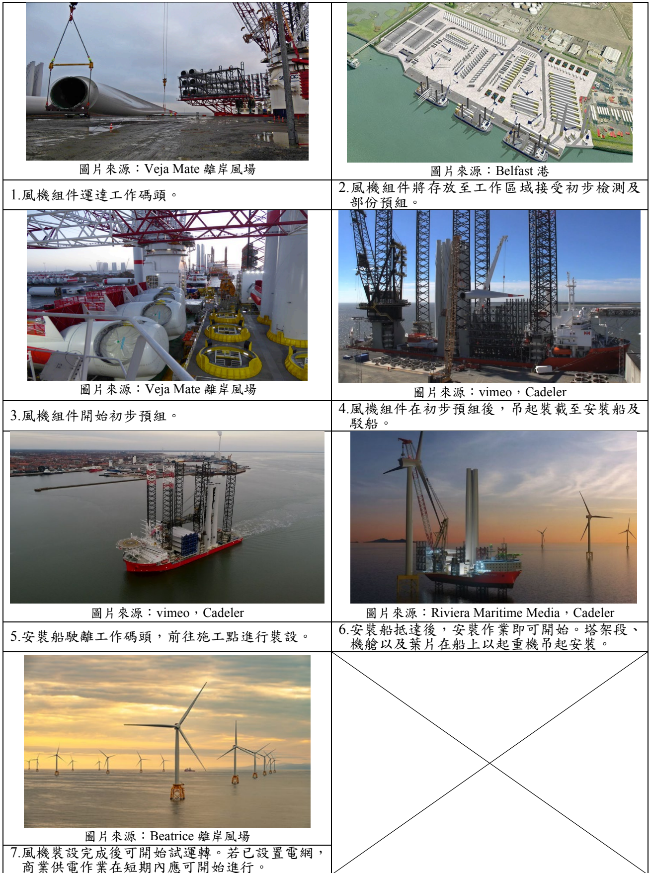
圖 4.2.3-4 風機運輸安裝作業示意圖
